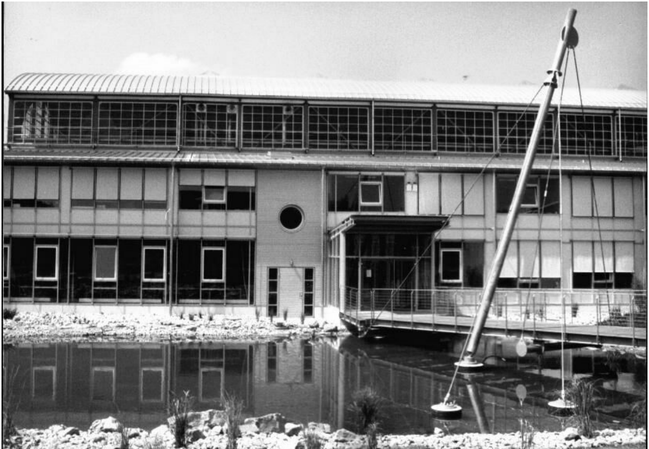
Foto Schwarz-Weiß mit neuer Zugang über Stahltreppe zu den Forschungs- und Verwaltungsräumen und der Konstruktions- und der Forschungshalle
