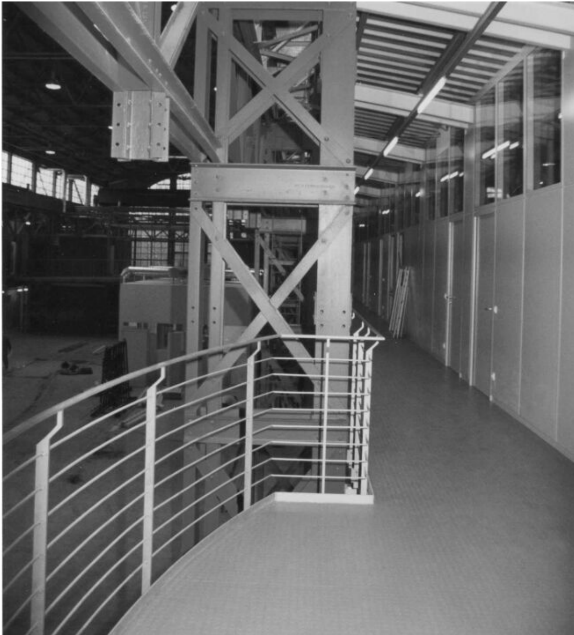
Foto Schwarz-Weiß Detail der eingebauten Zwischendecke in den Seitenschiffen mit Forschungs, Labors und Verwaltungsräumen
