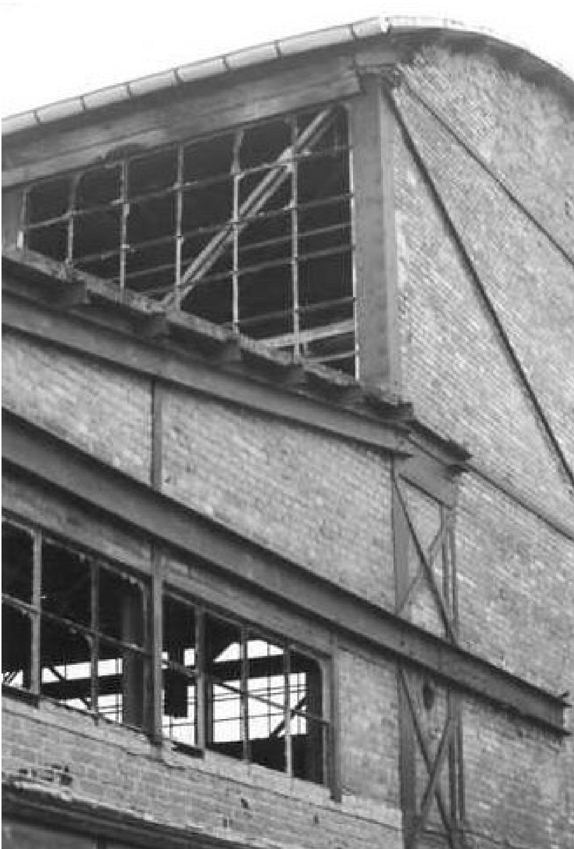
Foto Schwarz-Weiß / Detail der Ostseite der Halle vor der Instandsetzung, Renovation und Umbau zum ZIP-Zentrum
