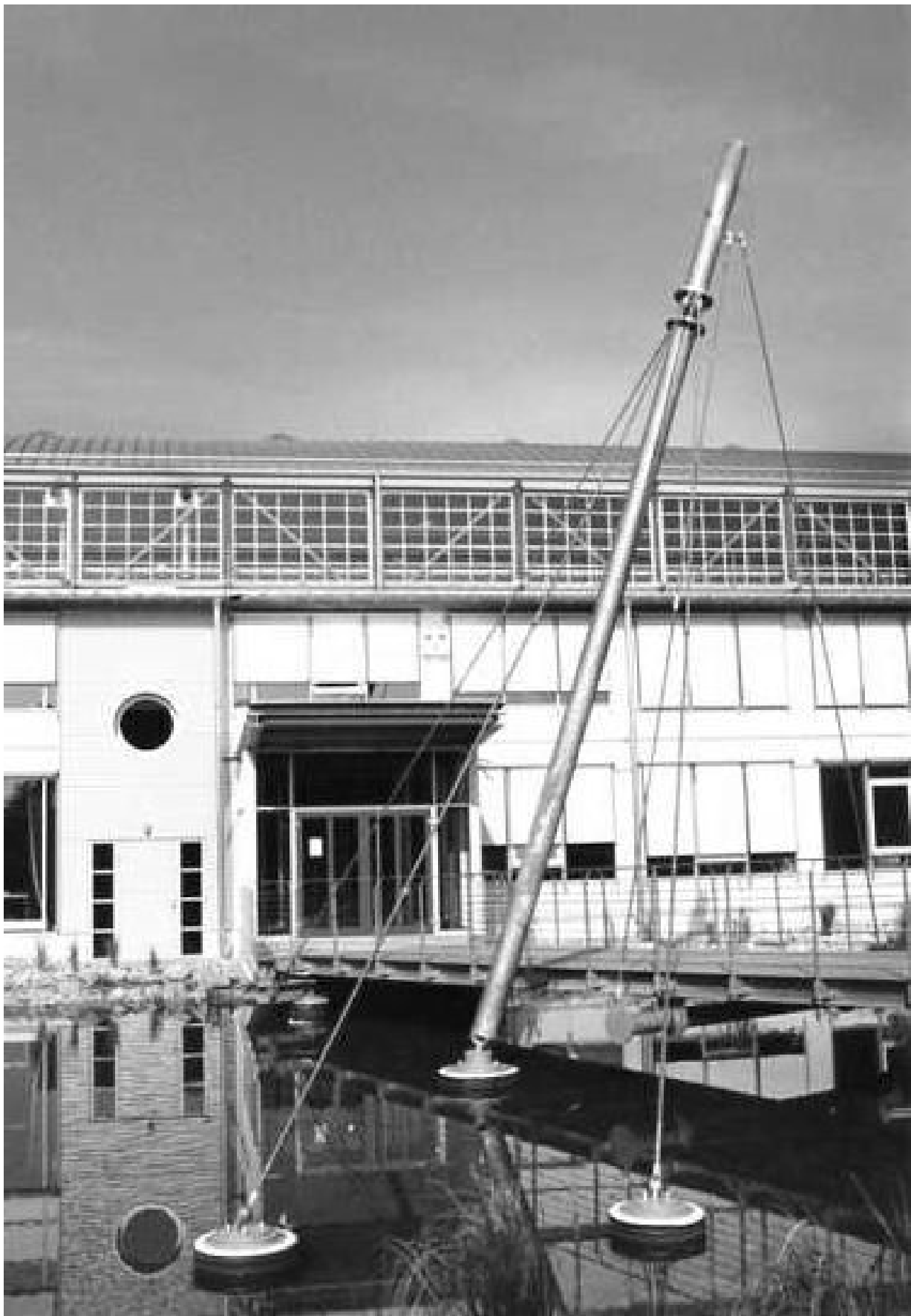
Foto Schwarz-Weiss des Hauptzuganges zum Versammlungsraum, den zweigeschossigen Forschungs- und Verwaltungsräumen
