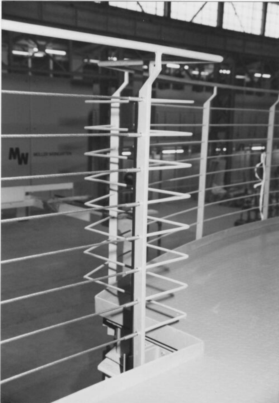
Foto Schwarz-Weiß mit Detail der Stahlgeländer des zweiten Geschosses der Forschungs- und Verwaltungsräume der beiden Seitenschiffe
