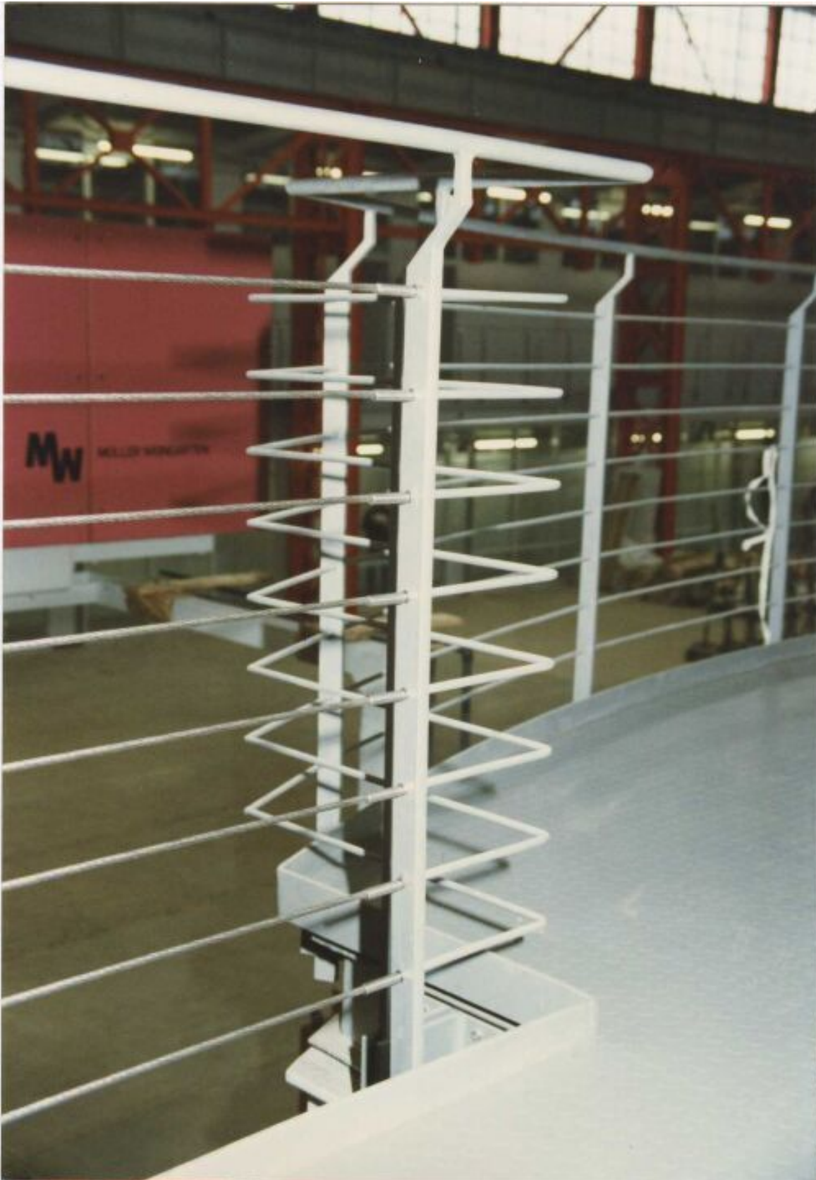
Foto Farbe mit Detail der Stahlgeländer des zweiten Geschosses der Forschungs- und Verwaltungsräume der beiden Seitenschiffe
