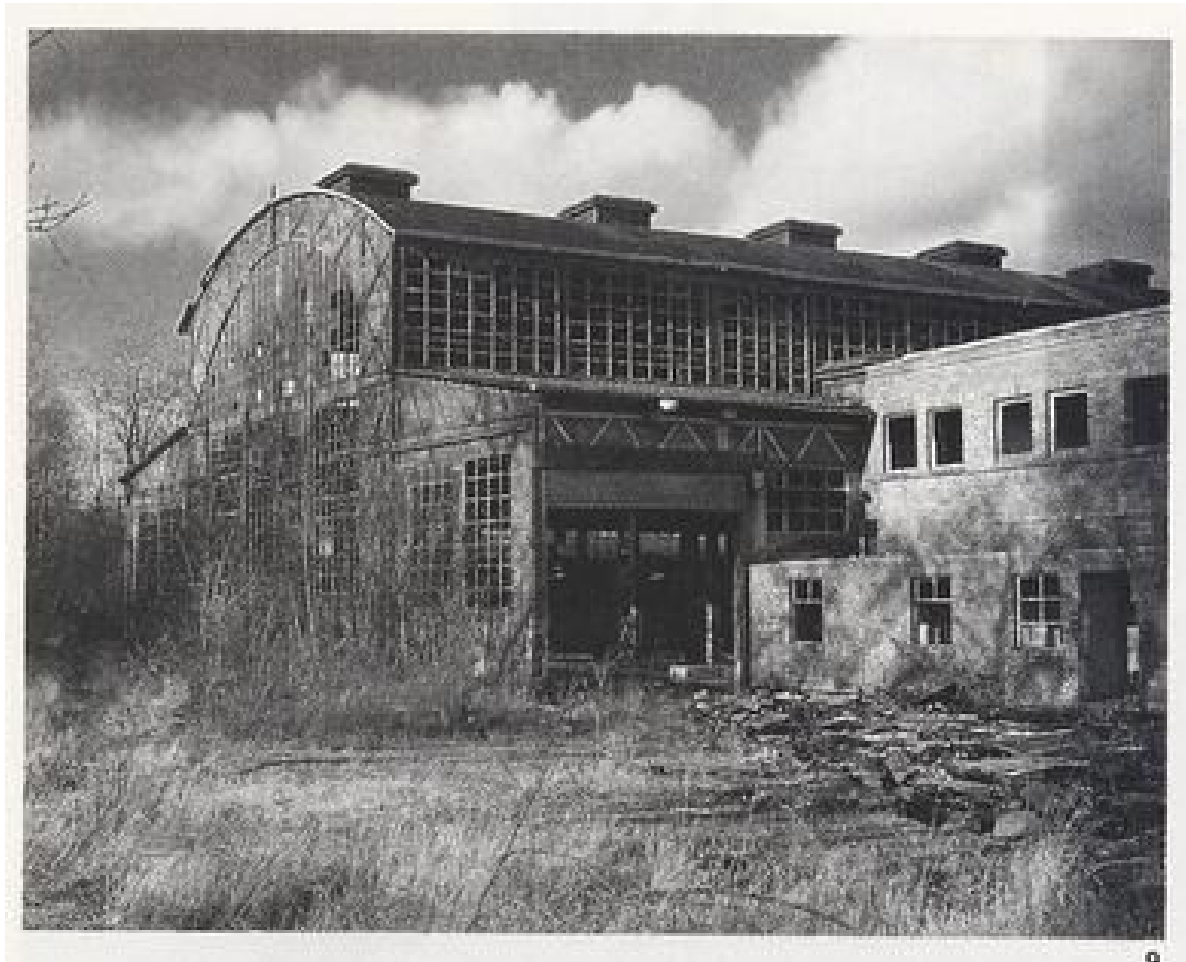
Zustand der ehemaligen Drahtseilhalle - vor der Instandsetzung -Umbau zum ZIP-Zentrum
