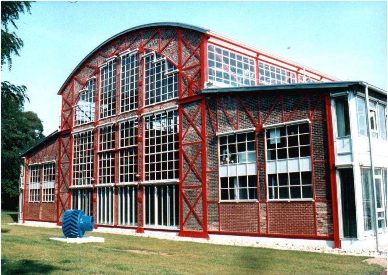
Ostfassade Farbe der ehemaligen Drahtseilhalle nach der Instandsetzung und dem Umbau von Büroräumen in zwei Geschosse in den Seitenflügel
